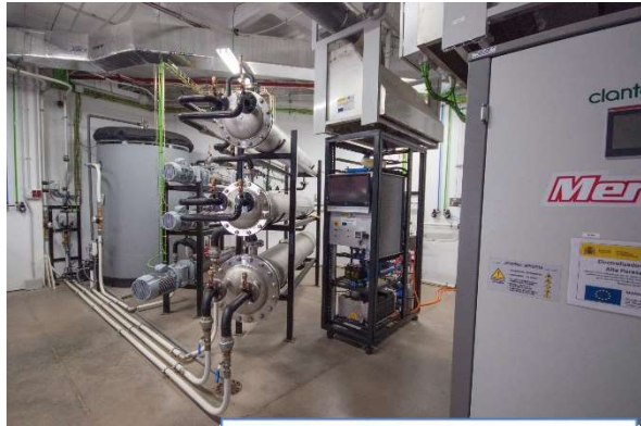
Instalación demostrativa ED
